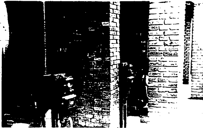
Bild 6: Pumpenhaus für Zwischentanklager 5, Splitterschutzmauern zwischen den Pumpen.
