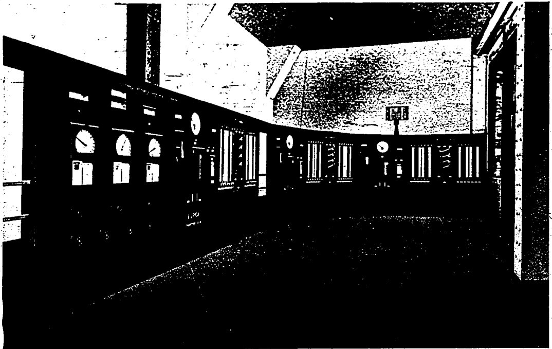
Abb. 11. Meß- und Regulierzentrale einer Mahlröcknungsanlage.
