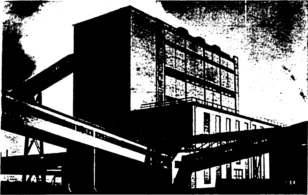
Abb 1 Mahl- und Ringpressenanlage für eine Tagesleistung von 1500 t Rohkohl.
