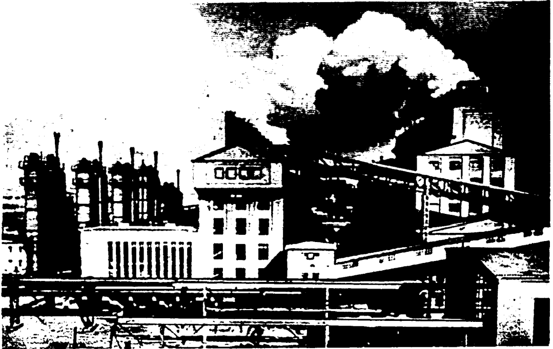
Abb. 5. Lurgi-Stückkoksanlage für eine Tagesverarbeitung von 5000 to Rohkohle.
