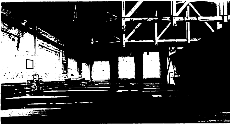
Aufenthaltsraum. Umfassungswände massiv. Überdachung in Holzkonstruktion mit Holzfachwerkbindern, eisensparend.
