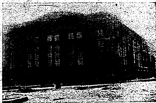
Рис. 2. Общий вид здания кислородной станции ДЗМО.
