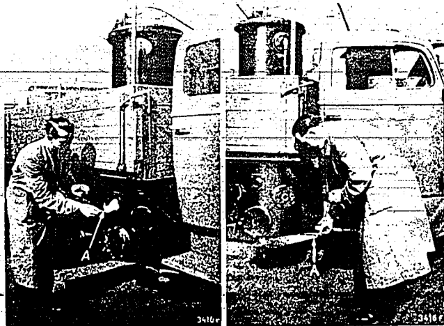
Bild 6b. Prüfen des Gases auf Zündfähigkeit am Gasprobierrohr
