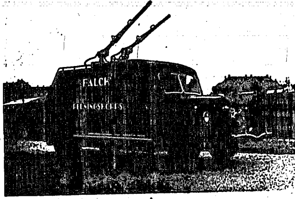
Abb. 1: Feuerlöschfahrzeug (bestückt mit Komet-Luftschaumrohren). Automobile des pompiers, muni de Lances Comète Fire-Brigade Car supplied with Comet Airfoam Branchpipes
