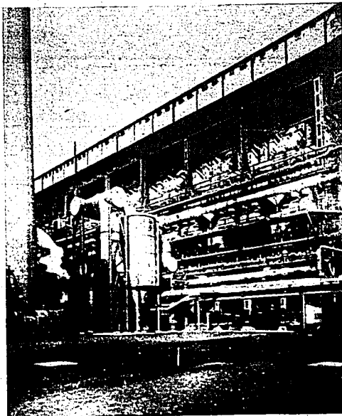
Abb. 2. Bubiag-Didier -Anlage zur Erzeugung von täglich 1 Mio. m 3 Synthesegas
