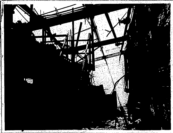
Bild-Nr. 59876/6 - Bau Nr 801 - Kohleaufbereitung - - Blick nach Süden - Bomben- und Brandschäden auf der Transportband - Bühne im obersten Geschoss an der Ostseite.
