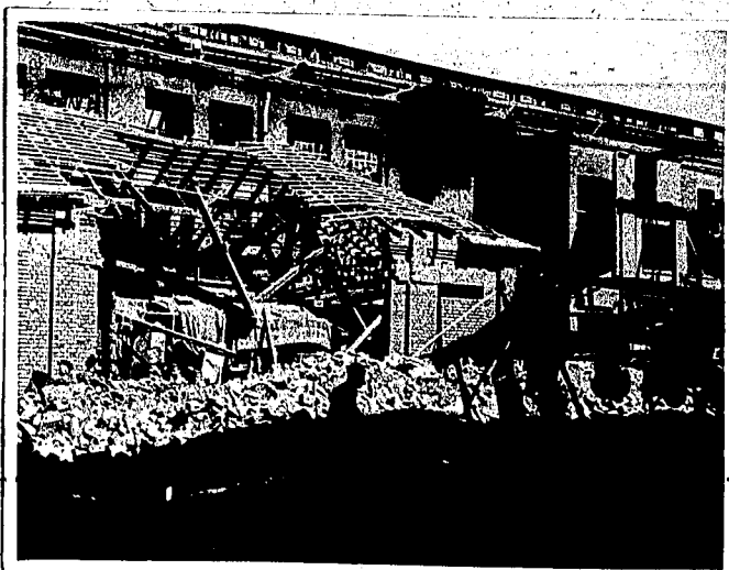
Bild-Nr. 59855/7a - Bau Me 15 - Hauptwerkstätte und Bau Me 88 - Unterstation - Nochmalige Zerstörung der Anbauten an der Westseite von Bau Me 15 und des Mit- telteiles der Unterstation Bau Me 88. Das vom 1. An- griff, am 28.5.1944, kaum fertiggestellte Dach wurde erneut zertrümmert, gemau- erte Außenwände und die Dachkonstruktion waren ein- gestürzt und müssen von Grund auf neu hergerichtet werden.
