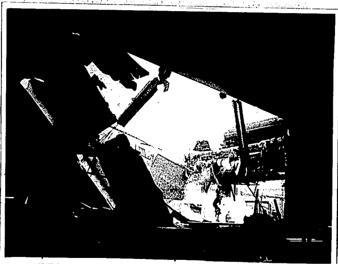
Bild-Nr. 59874/36 - Bau Me 109 - Speiseanstalt - Innenaufnahme nach Norden - eingestürzte Eisenbe- tondecke des südlichen Speisesaales. Im Hinter- grund Dampfleitungen auf der Rohrbrücke durch Splitter beschädigt und noch nicht abgedichtet.
