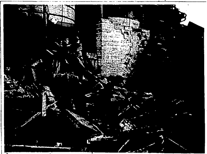
Bild-Nr. 59790/5 - Bau Me 117x - Behälteranlage - - Splitterschutzwand -
